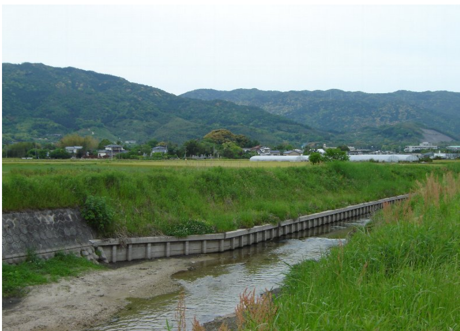
施工後1年2ヶ月
