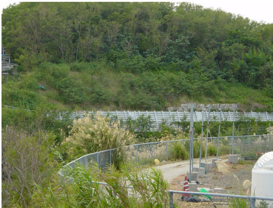
施工後1年9ヶ月経過
