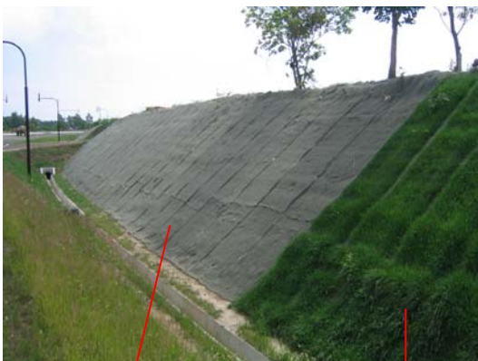
7月施工 施工直後 5月施工
