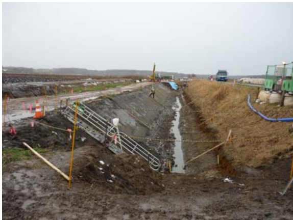
施工前(平成21年11月)
