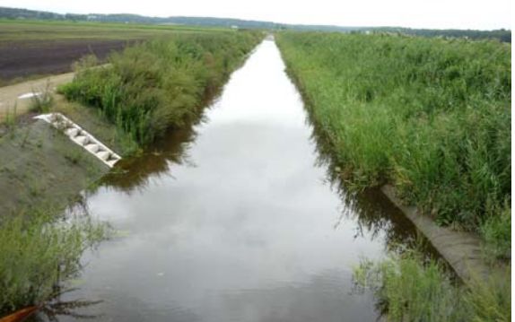
施工9ヶ月後(平成22年9月)
