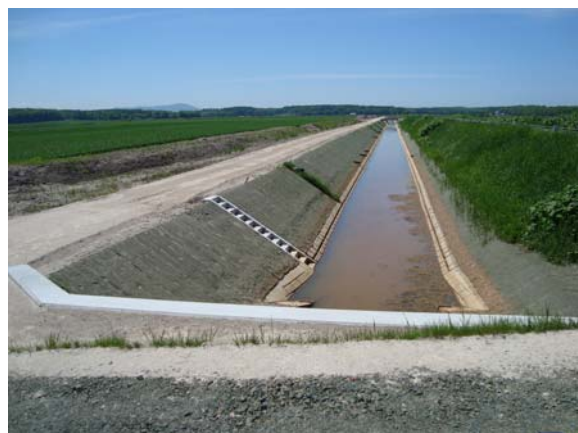
施工6ヶ月後(平成22年6月)
