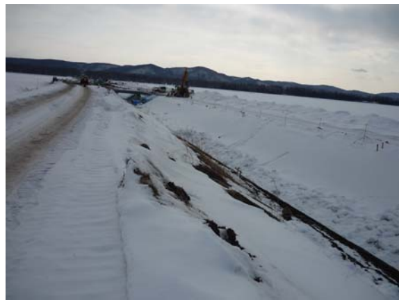
施工直後(平成22年1月)
