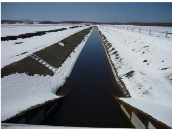
施工4ヶ月後(平成22年4月)
