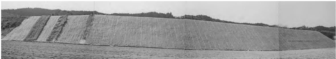
写真Ⅱ-4.3 本施工直後 (八重2号地)
