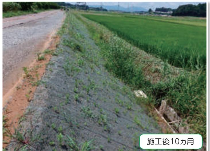
仮設保護。工事用道路法面の保護、隣接する農地への飛砂、濁水対策を目的に採用。
