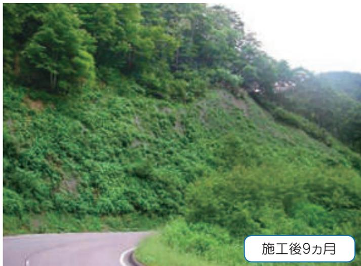
部分的な崩壊に対しての保護⇒植生。吹付工法と総合的に比較検討され採用。起伏に馴染ませながら施工している。
