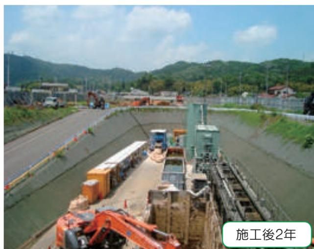
工事現場内で一時的な保護が必要な法面（仮設法面、工事用道路）への適用が可能です。多機能フィルターは、耐候性に優れるポリエステル製の繊維で形成された不織布（ウェブ）を使用しています。現場条件によって異なりますが、一定期間の保護が可能です。
