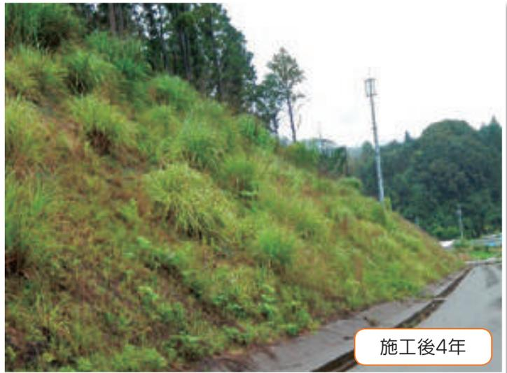
保護⇒植生。製品内に現地表土を装着し施工。植生が成立するまでの長期的な保護を目的として採用。
