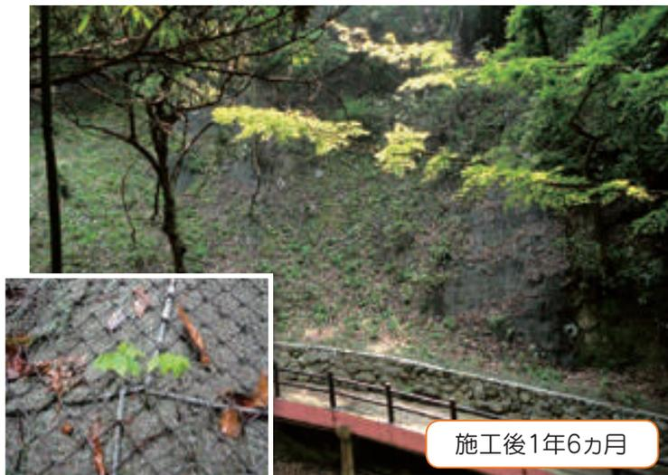
保護⇒自然植生。公園内。抑止工法で地山の安定確保、弊社製品にて現地植物での景観回復を行う目的として採用。
