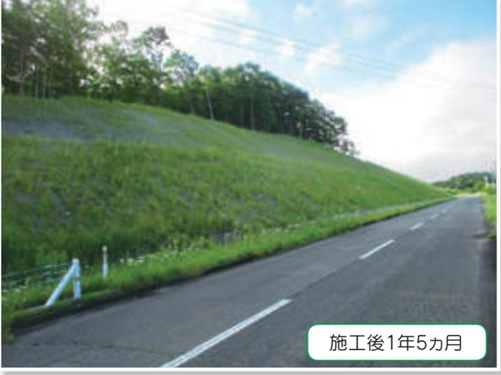
吹付⇒多機能フィルターでの養生。植生が成立するまでの間（越冬含む）、吹付けた表土の流出防止を目的として採用。
