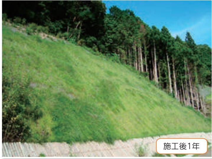
地下水対策⇒植生。地下水対策に伴う侵食防止目的で採用。地下水対策として、水抜きパイプを併用している。
