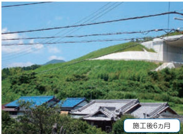
侵食防止⇒植生。降雨量が多い、高盛土という現場条件で、雨水の浸透抑制と表面侵食の防止を目的とし採用。
