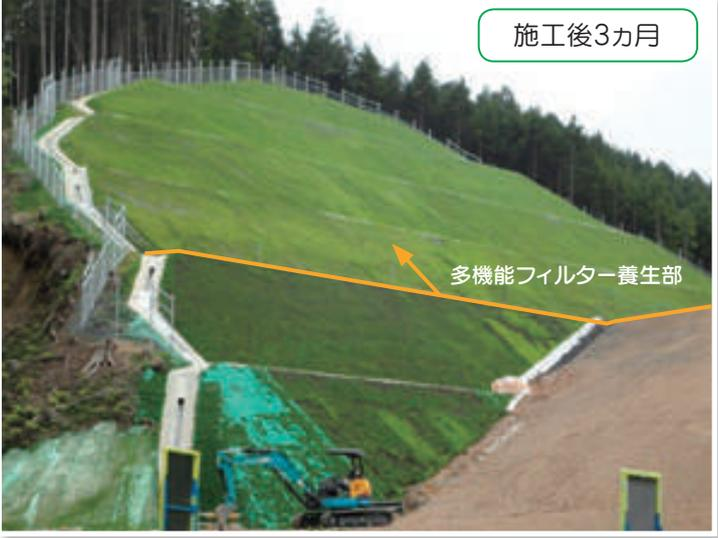
吹付⇒多機能フィルターでの養生。吹付基材の一部が侵食されたため、修復工法として採用。
