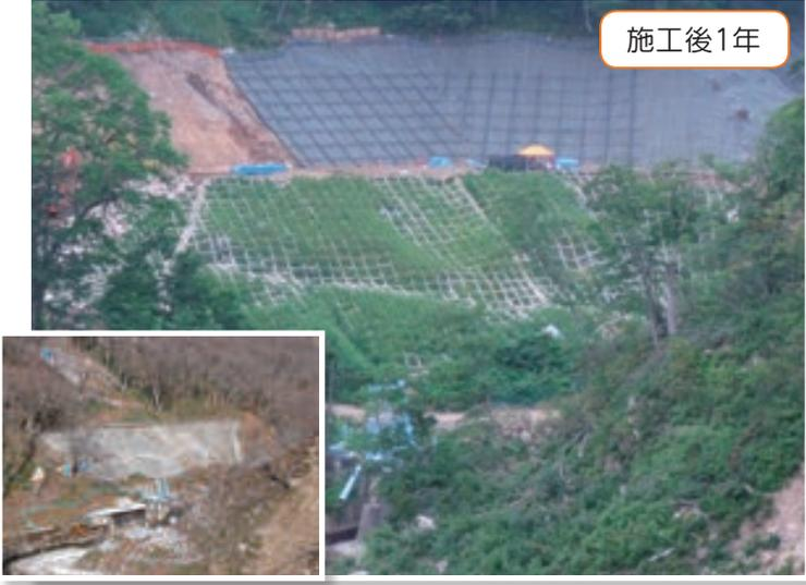
保護⇒植生。法枠背面の侵食防止及び植生。法枠施工前までの法面保護とその後の植生を目的に採用。
