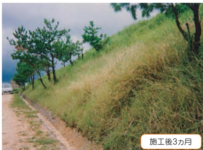
侵食防止・濁水対策⇒植生。造成工事。赤土(粘性土)流出対策を目的として採用。
