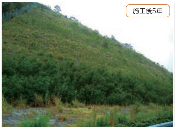
保護⇒自然植生。従来工法で施工も、植生が衰退してしまったため、補修案として採用。残存種子と周辺植物での植生に成功。
