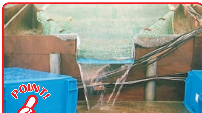
多機能フィルター 侵食を防止しているため濁水が発生していない
